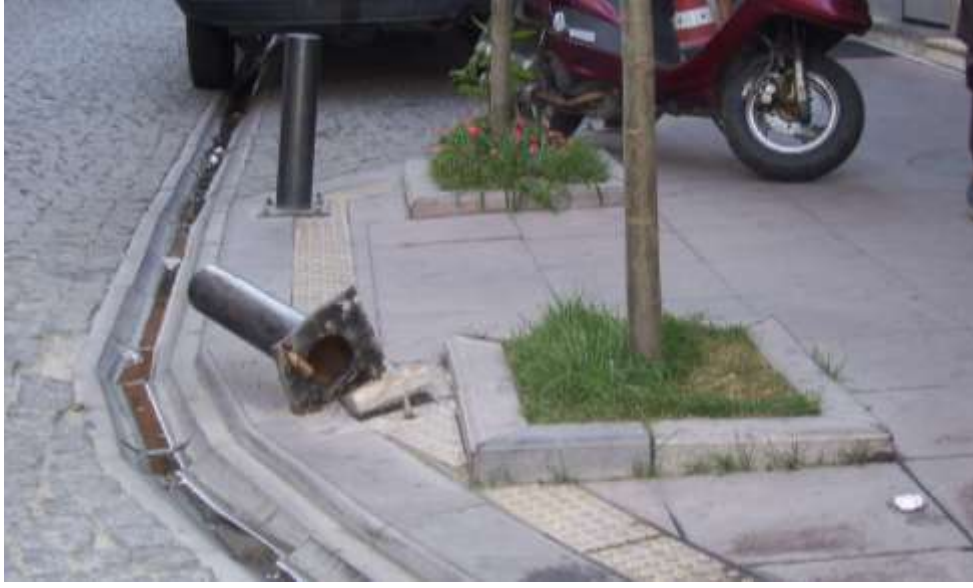
Şekil 5.28 Yanlış doku bandı uygulaması (f: Şükrü sürmen) 45
