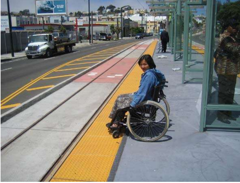
Şekil 5.27 Dokusal uyarıcı bantlar, yayaları tehlikeli bölgelere fazla yaklaşmaktan korur 44
