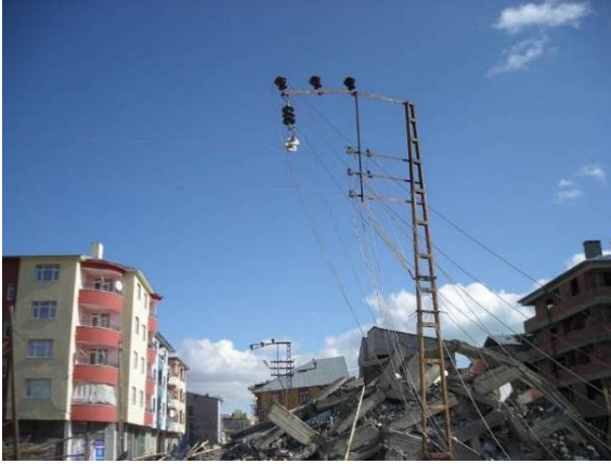
Şekil 5.47. Elektrik sistemlerine ait havai hat direkleri ve hasarları
