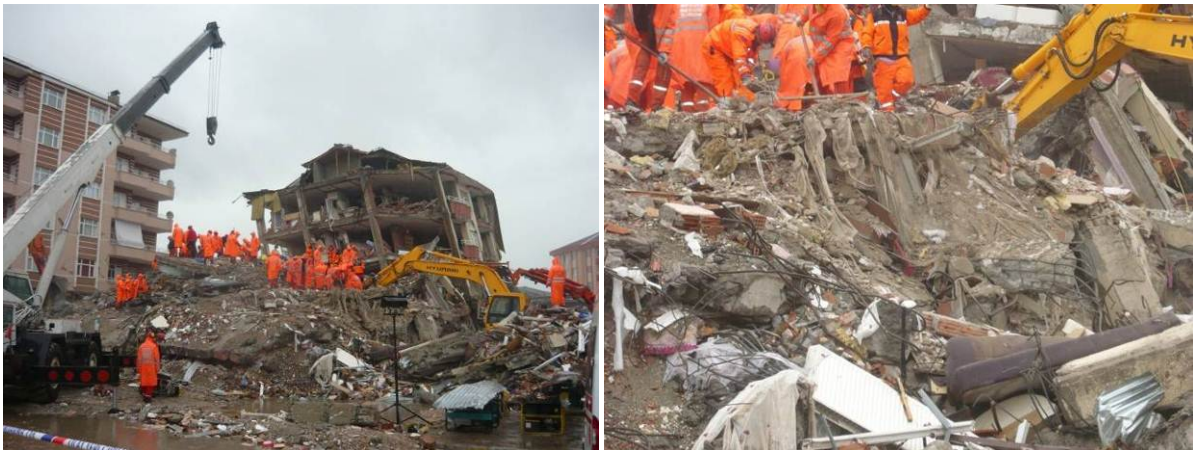
Şekil 5.13. Erciş Van yolu caddesi üzerinde tamamen kat mekanizması oluşarak göçmüş betonarme yapı
