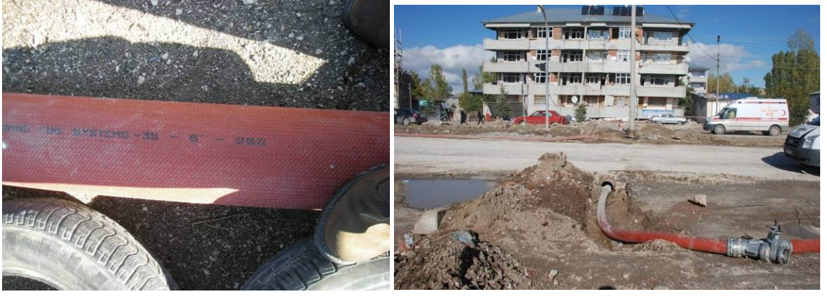
Şekil 5.52. 150mm çaplı ve 35 bar basınca dayanıklı yangın hortumları
