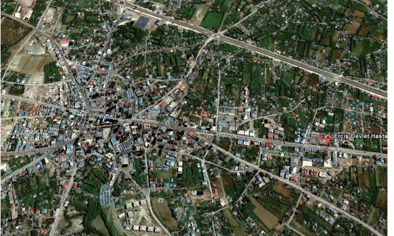
Şekil 5.11. Depremde en büyük hasarı gören Erciş İlçe merkezi uydu haritası
