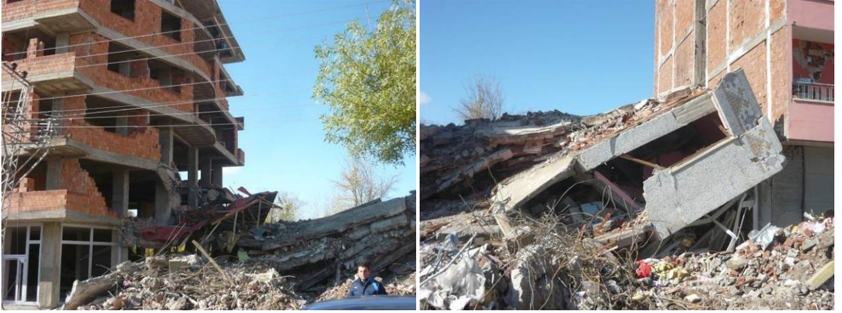
Şekil 5.21. Çekiçleme etkisi ile komşu yapılara çarparak yıkılan betonarme çok katlı yapı
