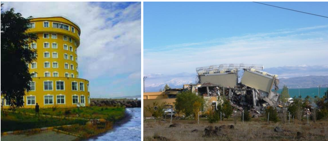
Şekil 5.30. Erciş’de Van Gölü kıyısındaki Arsisa Otelin depremden önce ve sonraki durumu
