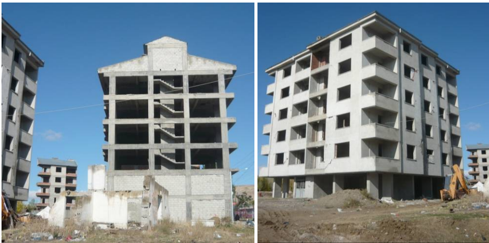
Şekil 5.20. Yıkılan yapıların hemen yanında bulunan hasarsıza yakın betonarme yapılar
