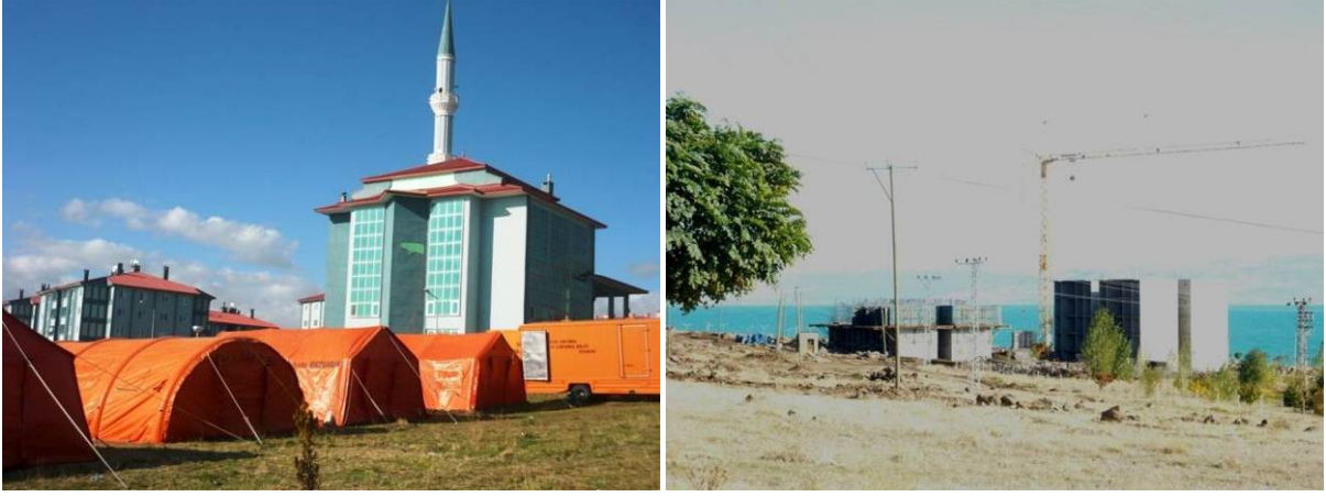
Şekil 5.29. Erciş’de Van Gölü kıyısında yapılan TOKİ konutları camisi ile yapımı devam etmekte olan tünel kalıp çok katlı yapı inşaatları
