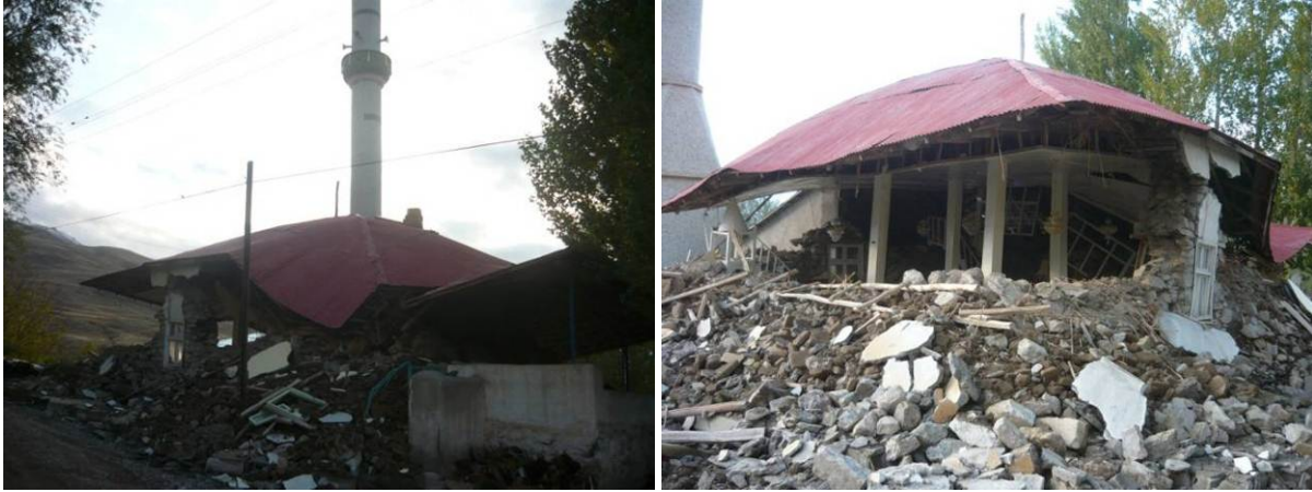
Şekil 5.43. Dağönü köyü camisinin depremden sonraki durumu
