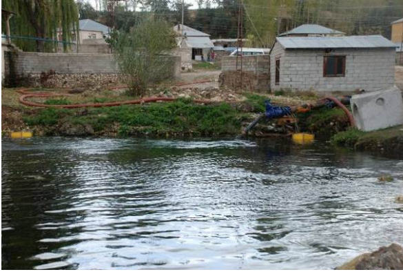
Şekil 5.50. Su kaynağı ve terfi sistemini sağlayan iki jeneratör beslemeli pompa
