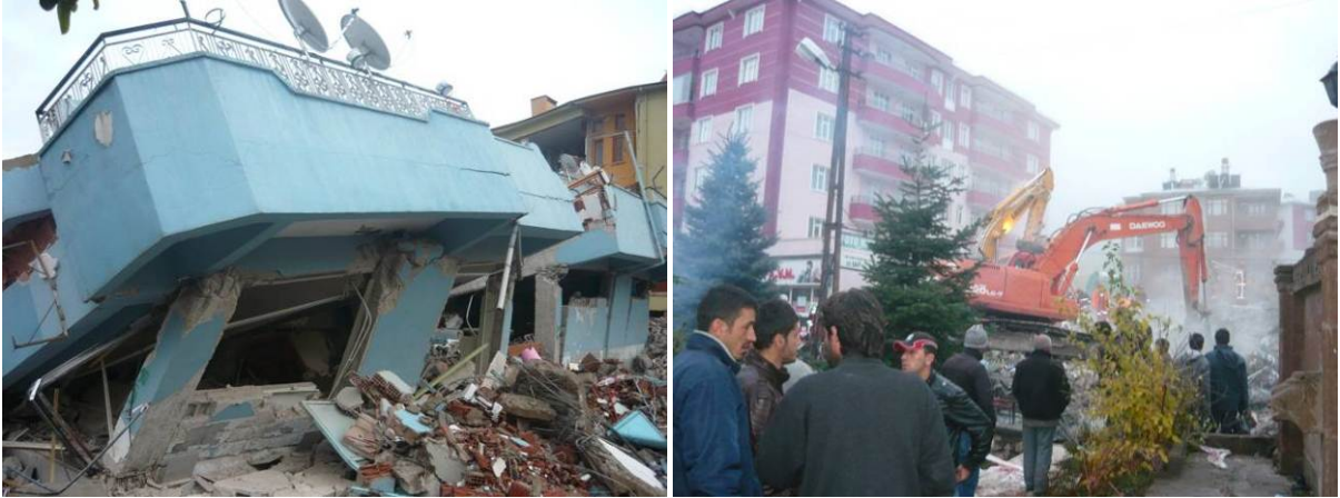
Şekil 5.15. Van yolu caddesinde aşırı yanal ötelenme sebebi ile göçmüş yapı
