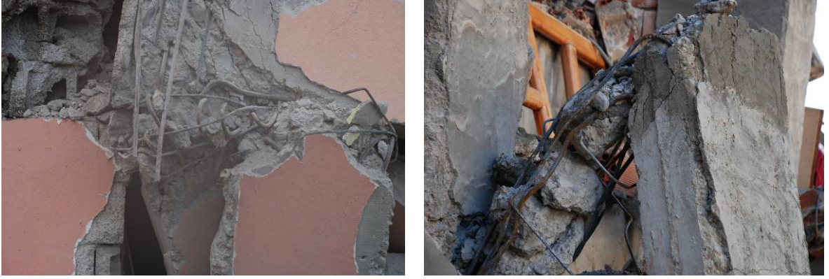
Şekil 5.34. Yetersiz sargı donatısı
