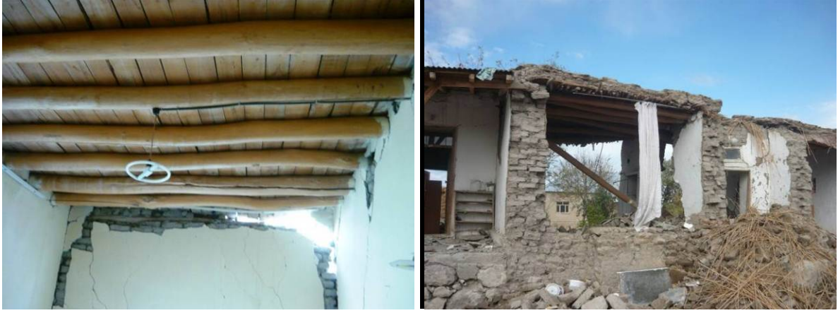
Şekil 5.40. Van yöresinde kırsalda yaygın olan kerpiç yapıların durumu
