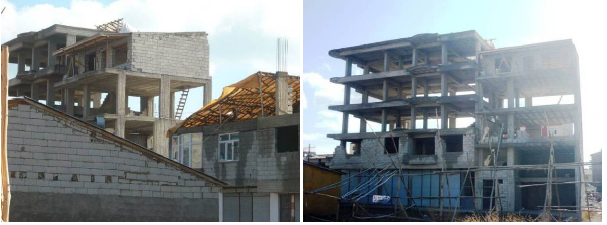
Şekil 5.28. En üst katında kolonda ani rijitlik değişimi olan betonarme yapı
