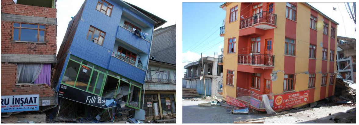
Şekil 5.32. Yumuşak kat nedeniyle hasar gören binalar
